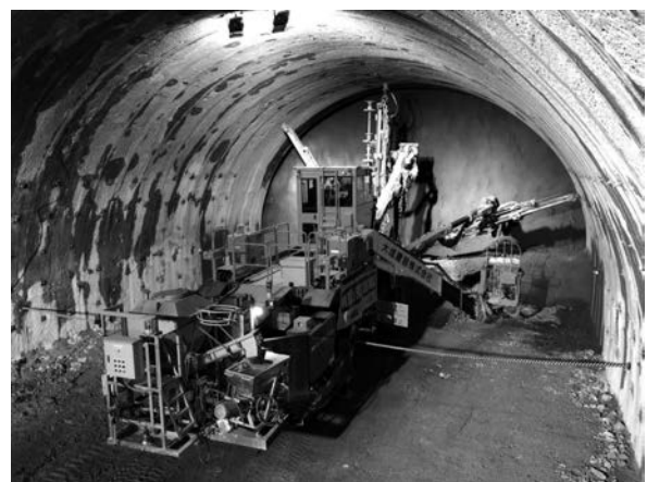
図-11 本技術の施工状況 (2号機)
