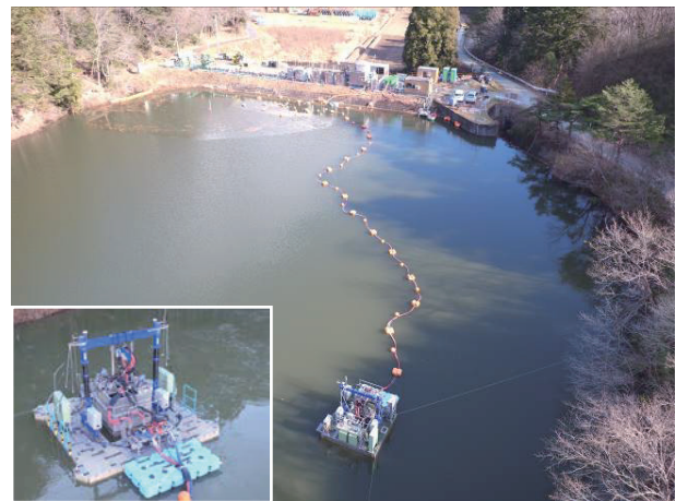
写真-4 ため池での施工
