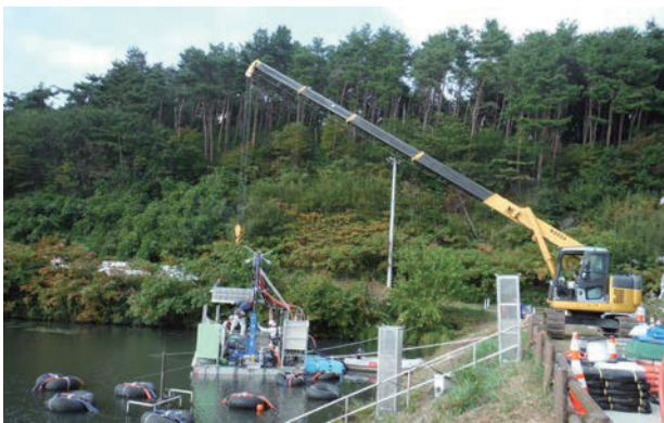
写真-2 機材組立状況
