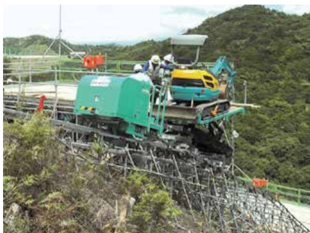
写真 - 1 橋梁下部工事にて傾斜地でモルタル荷台を角度補正
