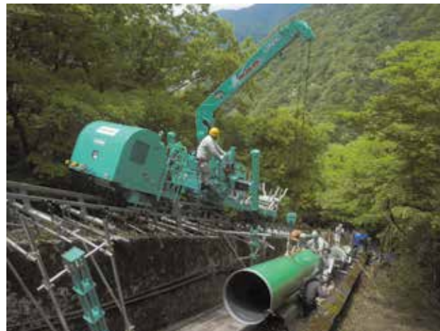
写真 - 4 改良版クレーン台車により吊り作業能力を向上
