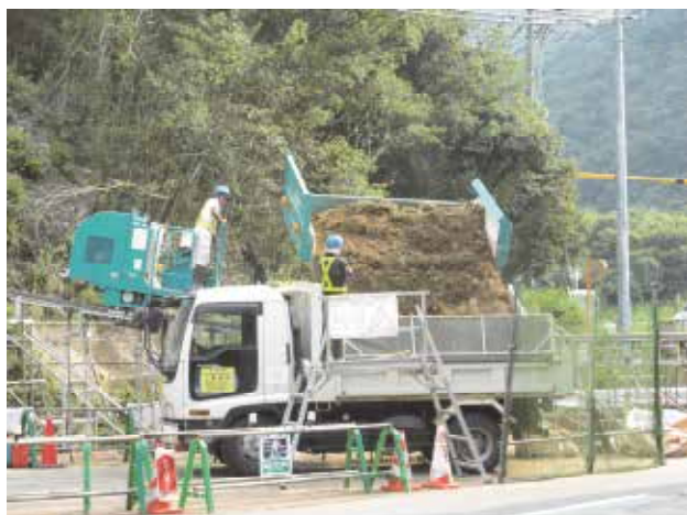
写真 - 3 改良版Fゲータング台車により土砂搬出効率を向上
