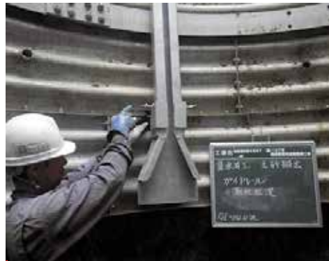
写真-2 ライナープレートへの取り付け
