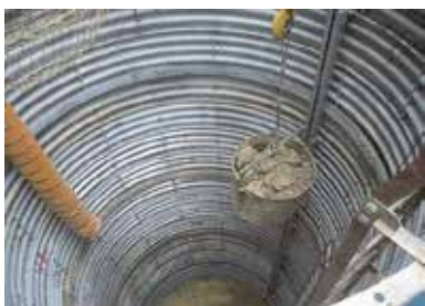
写真-3 セーフティガイドレール移動状況
