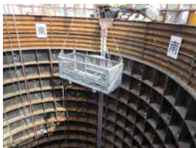
写真-4 鋼製籠を活用しての搬入状況
