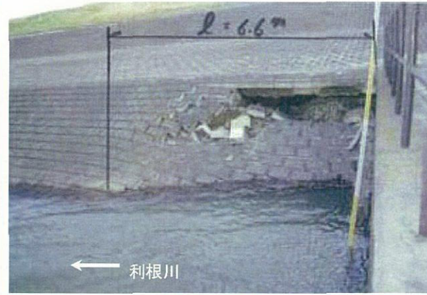
右岸下流側の状況
