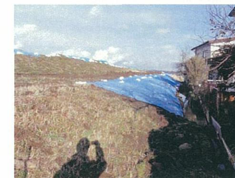
川裏側のり尻の状況 (3/16)
