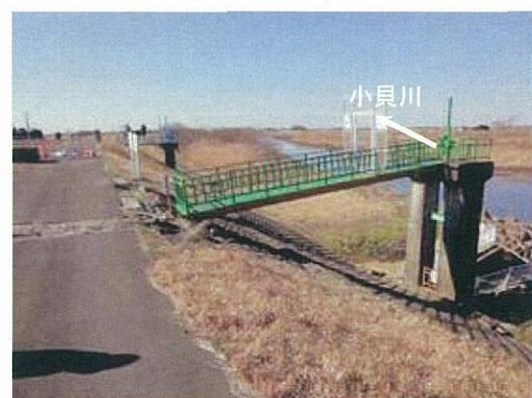
下流側の樋門管理橋の落座 (3/18)
