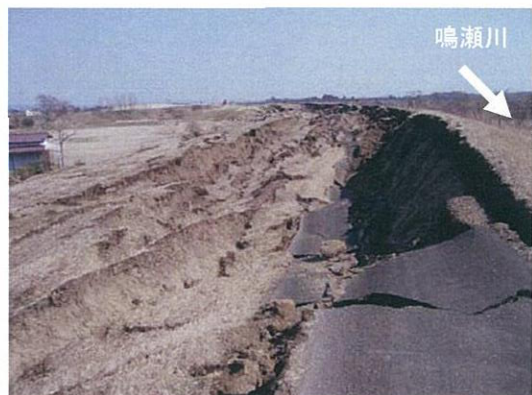
堤防天端～川裏側のり面の状況(3/13)
