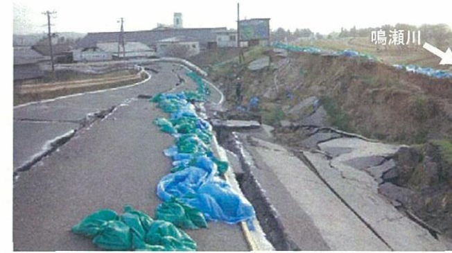
堤防天端～川裏側のり面の状況(4/15)
