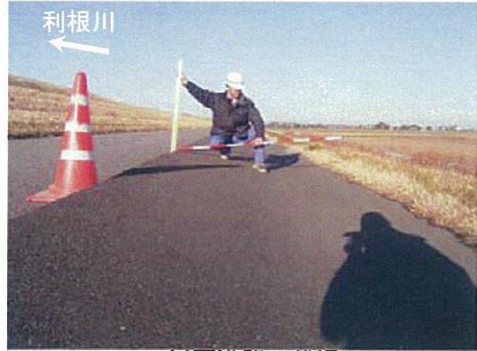
川裏道路の状況
