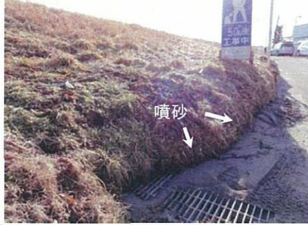
川裏側のり尻付近(3/16)
