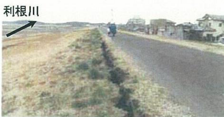
天端のり肩の状況
