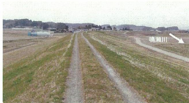
川表～天端～川裏の状況 (4/15)
