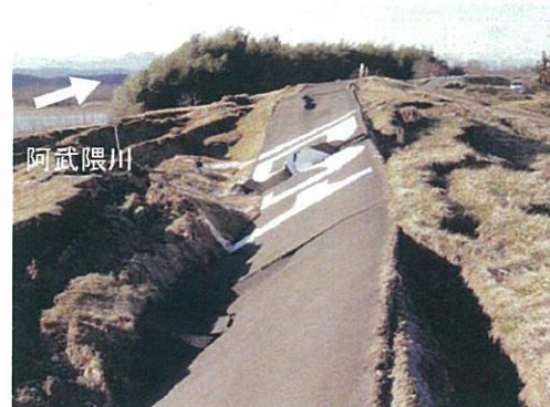
天端の状況 (31.0k付近より下流側を望む, 3/18)
