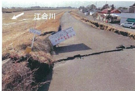
天端の状況(上谷地橋から上流側を望む, 3/16)
