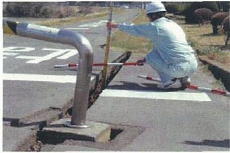
天端舗装の状況
