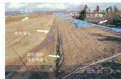
天端および表のりの状況 (3/16)
