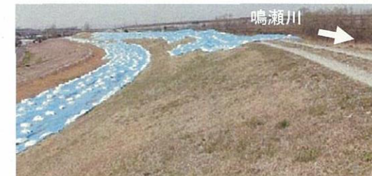
川裏のり面の状況 (4/15)
