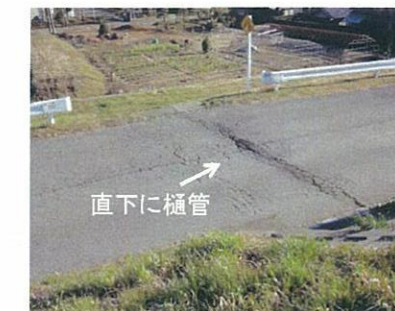
樋管上部裏小段の沈下および階段の亀裂(3/18)
