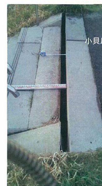
川裏のり面に設置された階段
