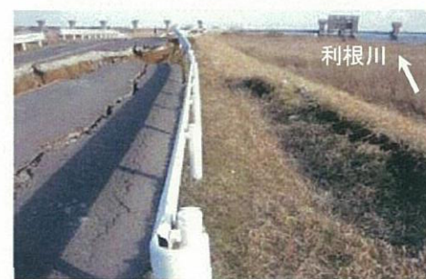
天端・のり肩の状況
