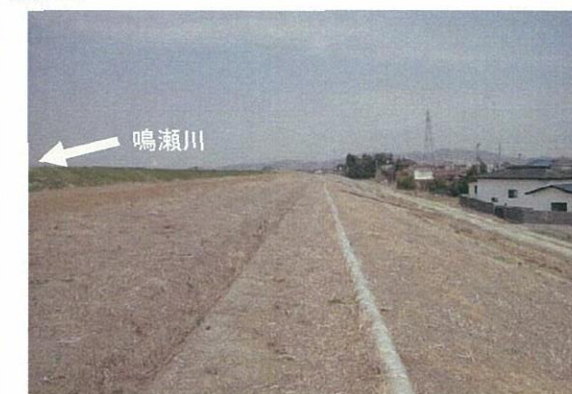
川裏第1小段の状況(上流側, 4/15)
