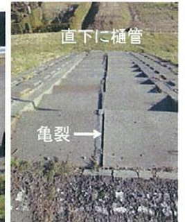
樋管上部裏小段の沈下および階段の亀裂(3/18)
