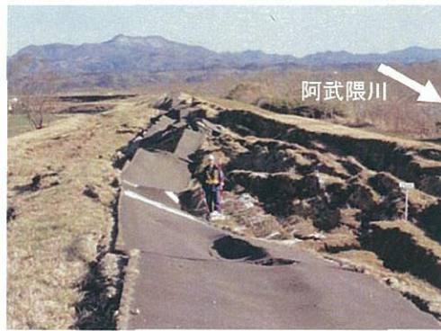
天端の状況 (31.0k付近より上流側を望む, 3/18)
