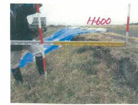
川裏のり肩の状況
