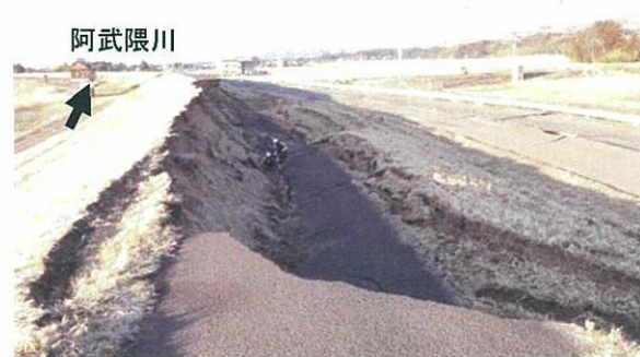
天端の状況 (33.0k付近から下流側を望む, 3/18)
