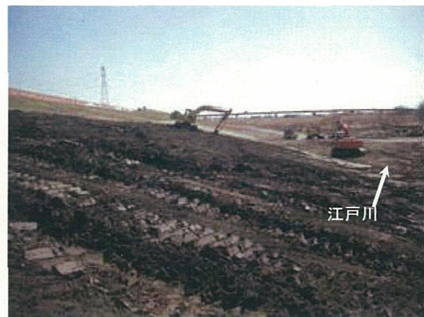
川表側のり面の状況(3/18)
