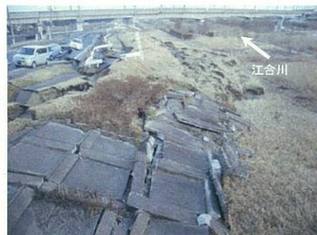
天端～表のり尻の状況(3/12)
