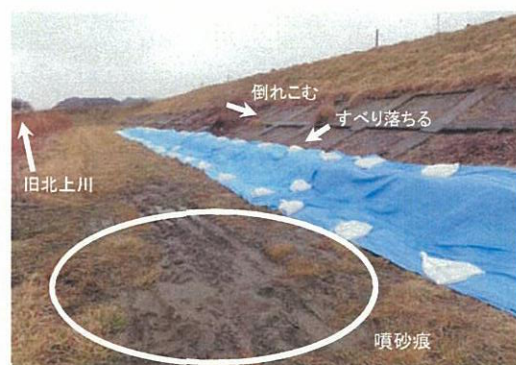
川表側のり尻付近 (3/16)
