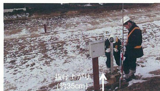
堤体内水位観測点(裏のり, 3/17)
