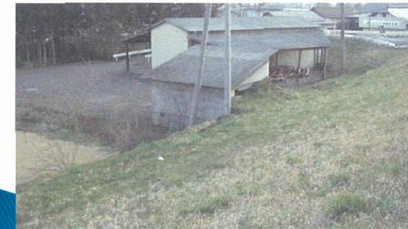
民地に達した崩土(4/15)
