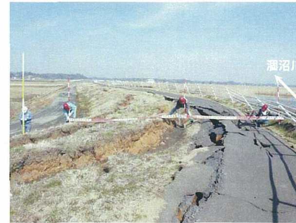
天端および川裏の状況
