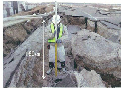
天端(市道兼用堤防)の状況(拡大)(3/17) 2)
