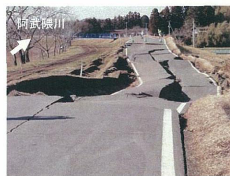
天端の状況(22.5kp付近より下流側を望む, 3/18)
