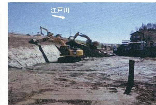
川裏側のり尻部の状況 (3/18)
