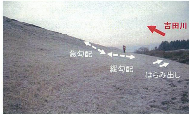
のり面の状況 (3/13)
