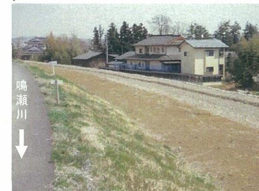
川裏第1小段の状況(上流側, 4/15)
