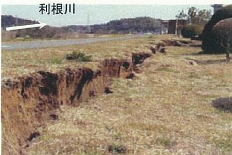
天端裏地の状況
