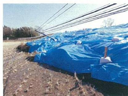
裏のり尻付近(3/18)
