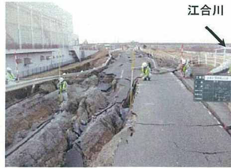
天端(市道兼用堤防)の状況(3/17) 2)
