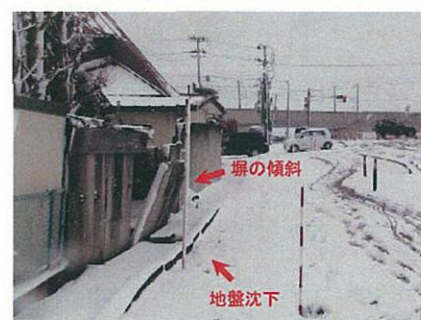
川裏側の民家付近の地盤変状(3/17)
