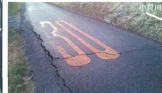
川裏側坂路の状況
