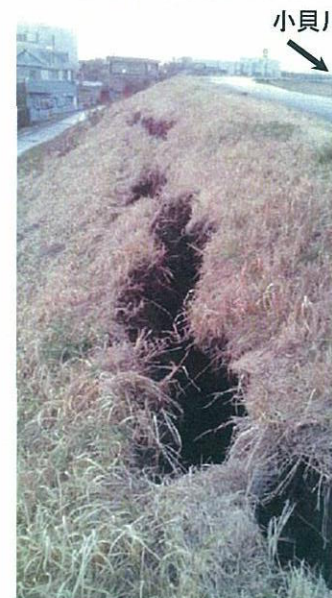
川裏のり面の状況
