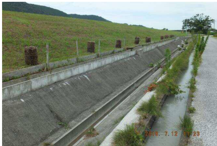
写真 4.8.1 裏法尻の堤脚水路
