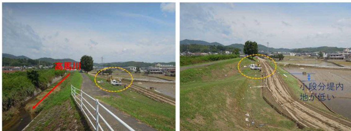
写真 4.1.4 高馬川破堤箇所近傍の堤内地盤高 (軽トラの位置が概ね河床高程度)
