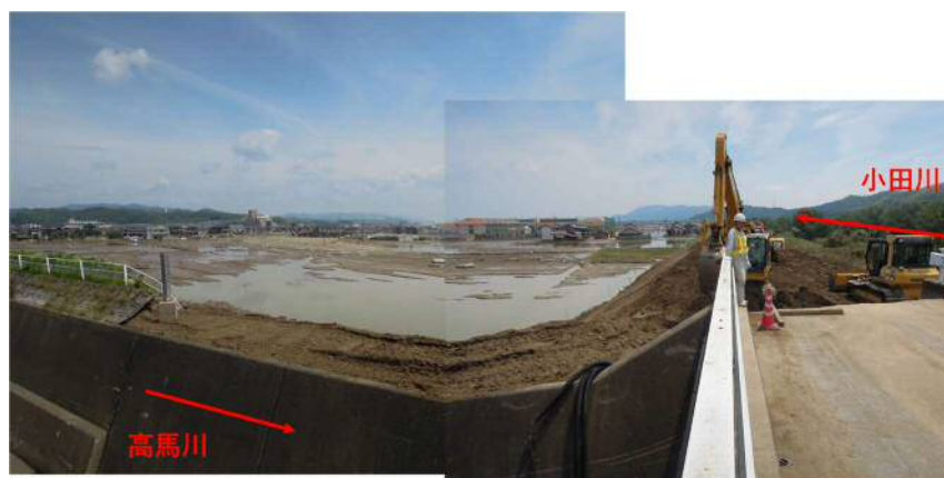
写真 4.1.5 破堤箇所の堤内地の状況
