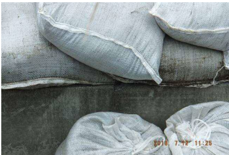
写真 4.8.3 プレキャスト水路の継ぎ手
