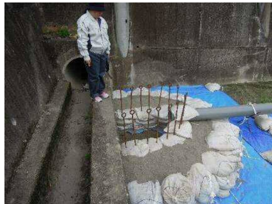
写真 4.5.3 月の輪 1 箇所
