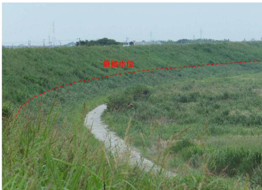
写真 4.4.1 吉野川 20.4k 付近の堤防表のり
