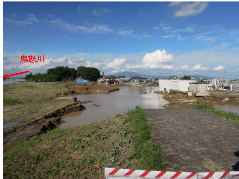
写真 2-4 決壊口下流側から上流側を望む
