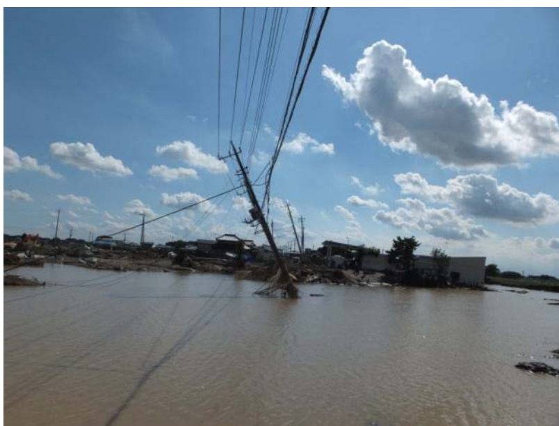
写真 5-2 決壊堤防（写真右側）の直近、道路も家屋も流出している
