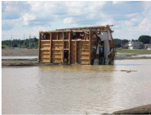
写真 1-6 流出し横転した家屋
