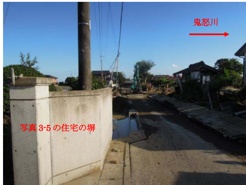
写真 3-4 鬼怒川越水箇所 の 堤内側宅地
