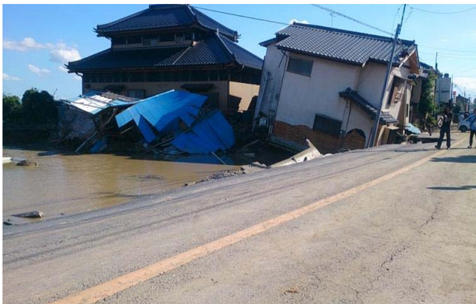
写真 5-3 洗堀により傾いている家屋
