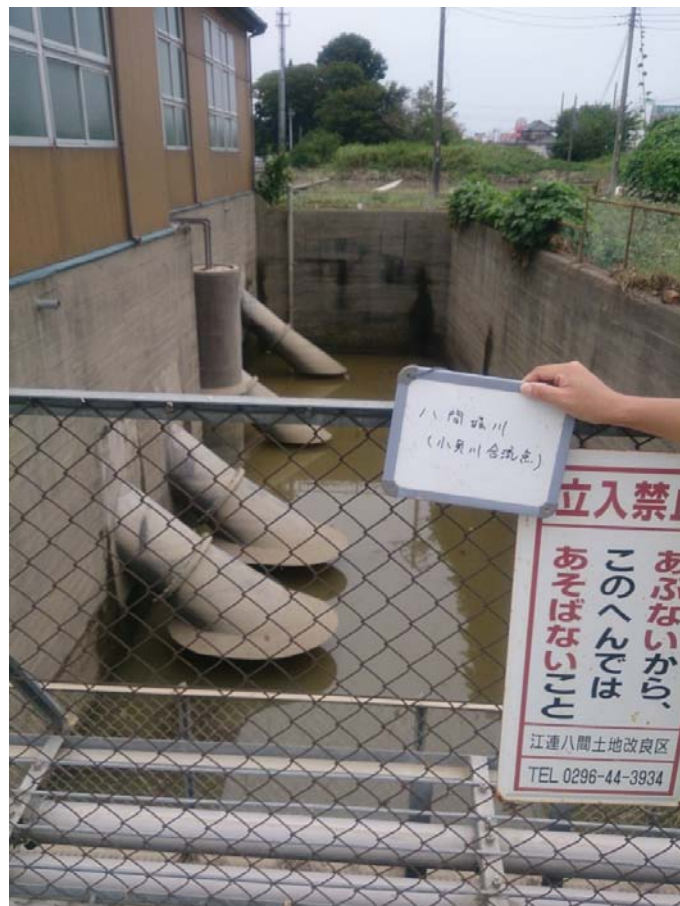
写真 4-22 排水ポンプ場の状況
