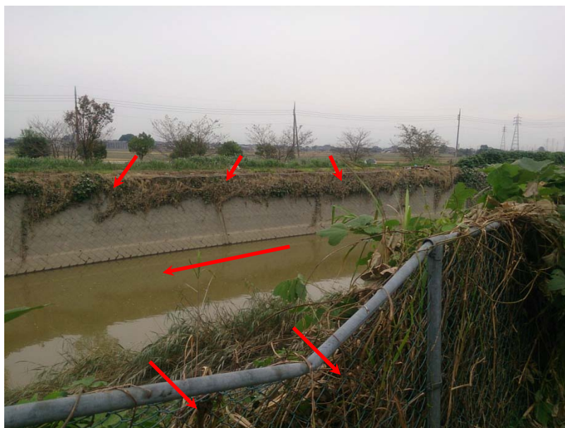
写真 4-16 八間掘川右岸からの流入と左岸からの流出が推測される（矢印は推定）
