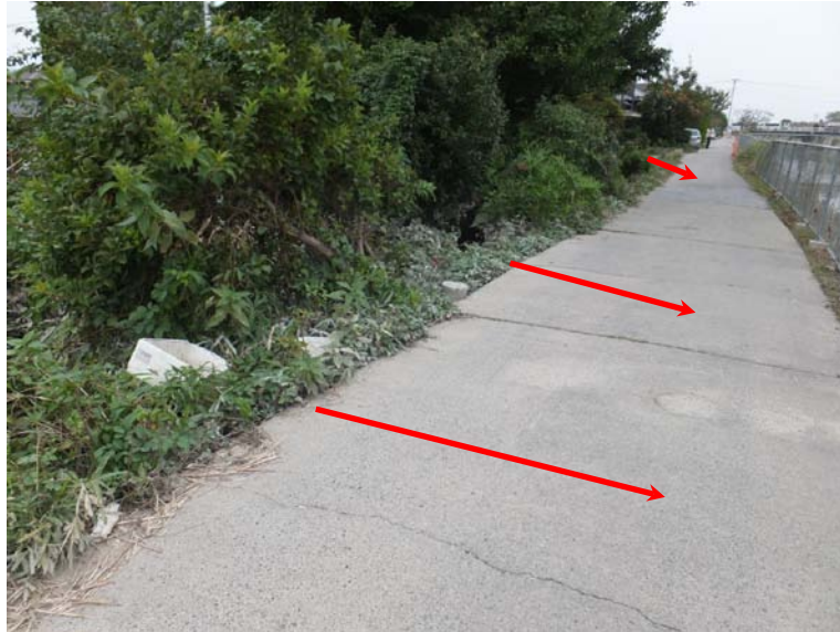
写真 4-7 八間掘川右岸側堤内地側から八間掘川への流入跡 (八間掘川右岸から上流側を望む)
