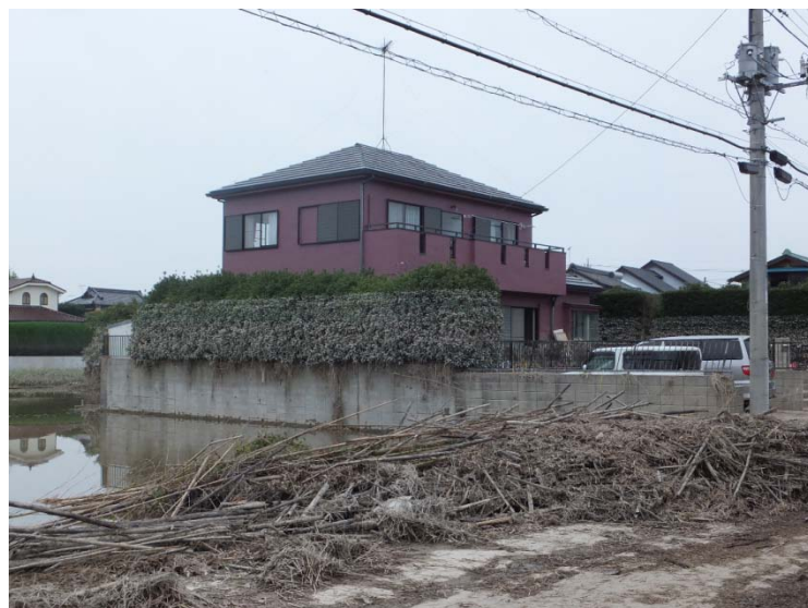
写真 4-4 堤防決壊箇所付近 浸水状況
