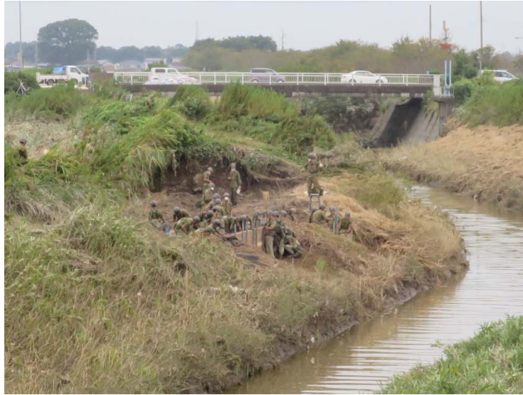
写真 4-2 堤防決壊箇所 復旧作業状況
