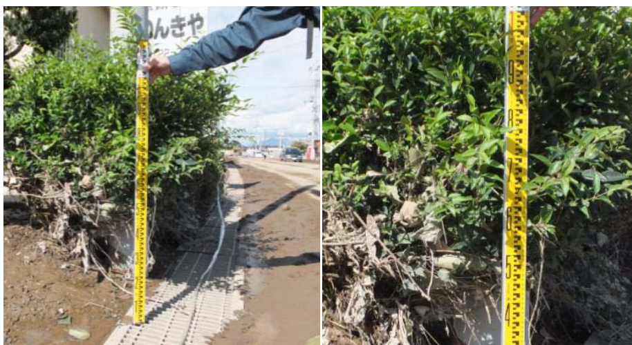
写真 5-18～5-20 浸水した家屋（水位は 70～80 c m）
