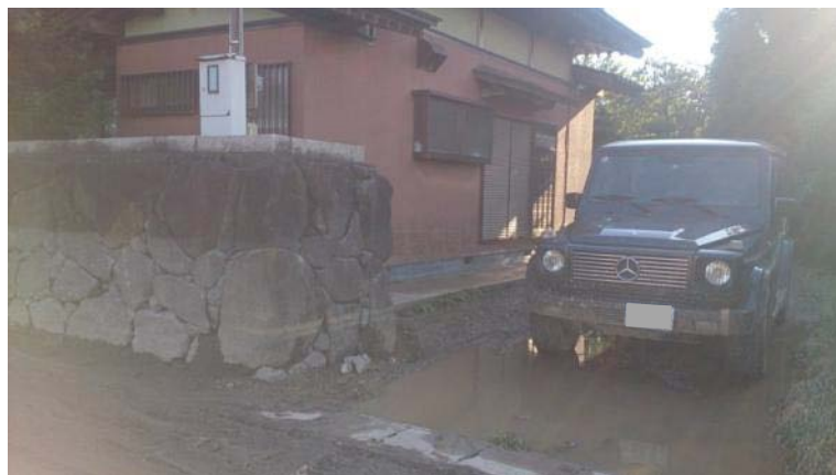
写真 5-27 家屋の入口、塀に浸水痕跡が残っている。
