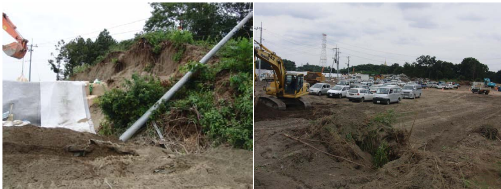
写真 3-13 左岸上流部末端箇所（堤内側から）
