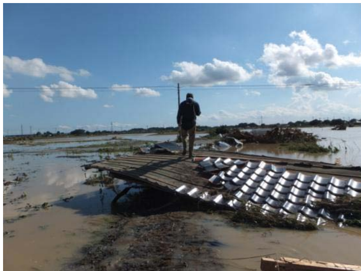
写真 5-13 流出した家屋
