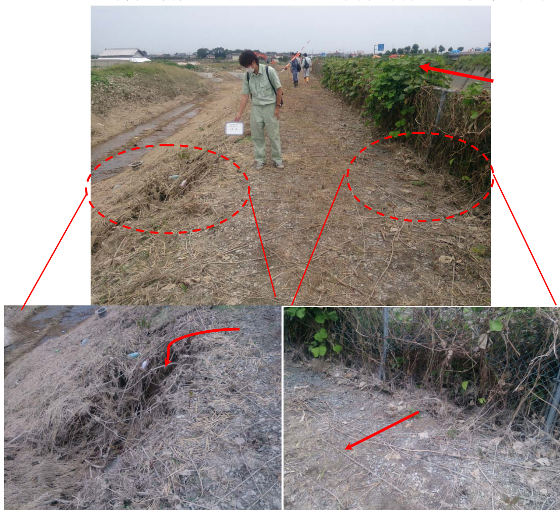
写真 4-17 八間掘川から堤内地への越水跡
