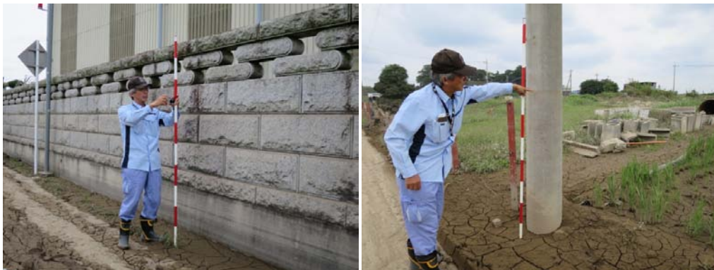
写真 3-8 痕跡水位（約 1.4m）
