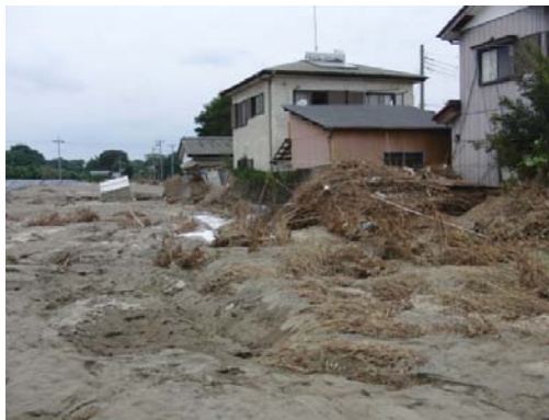
写真 3-16 復旧箇所堤内の被災状況
