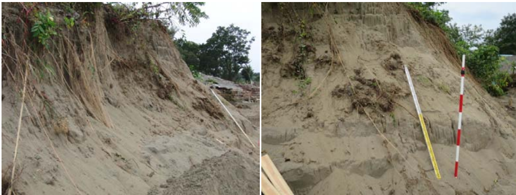
写真 3-15 左岸下流の端部状況
