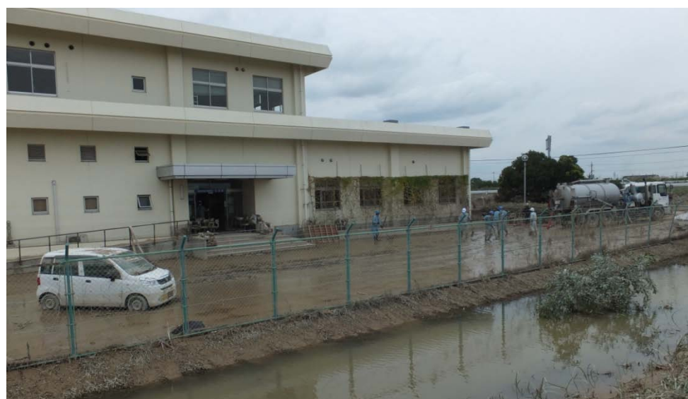
写真 6-8 浄水場内の状況
