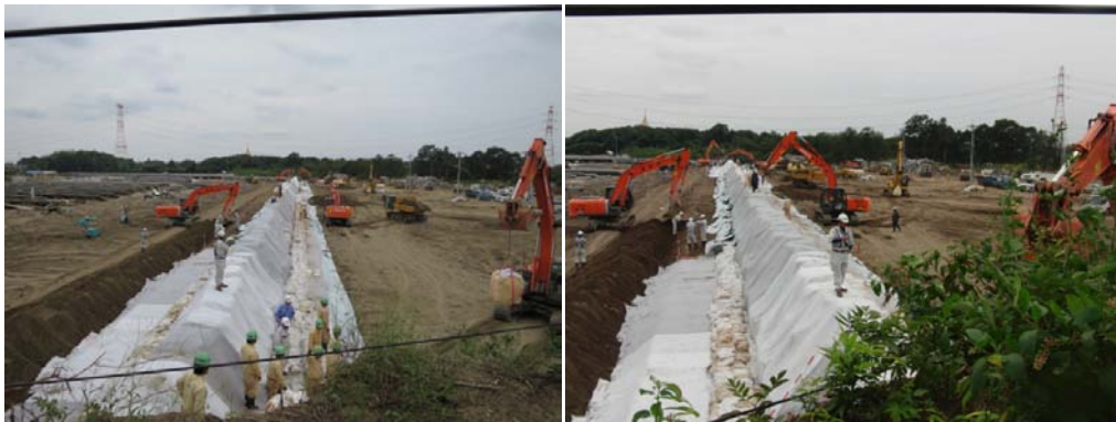
写真 3-12 痕跡水位左岸上流部から復旧状況を望む
