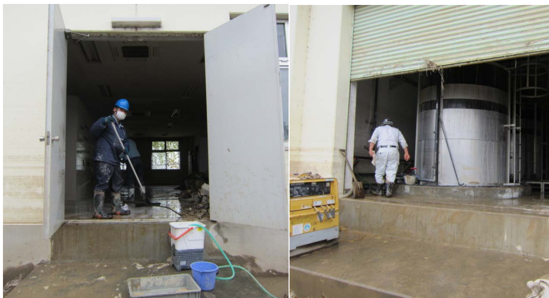
写真 6-13,6-14 浄水場内の清掃状況
