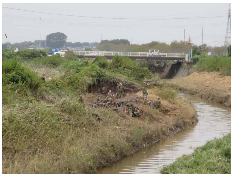
写真 4-1 堤防決壊箇所 復旧作業状況
