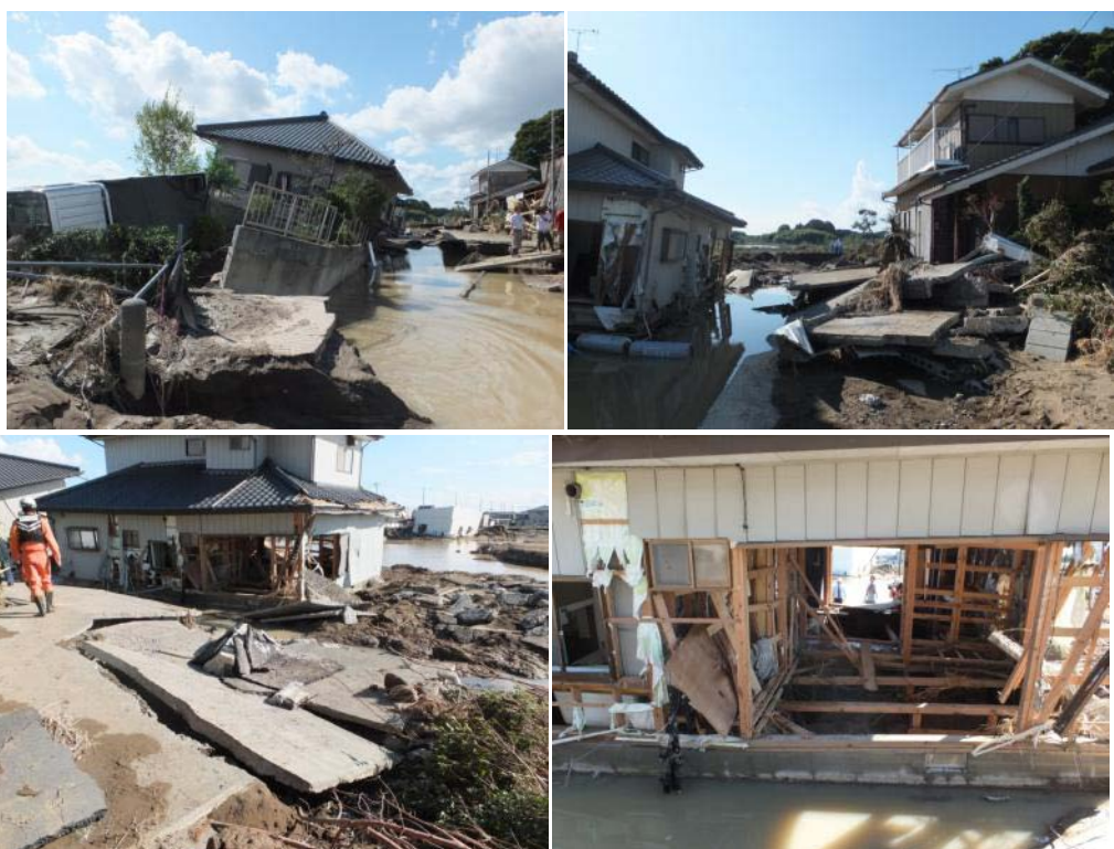
写真 5-4～5-7 決壊した堤防の上流側の家屋、大きく損傷するとともに、 洗堀により傾いている
