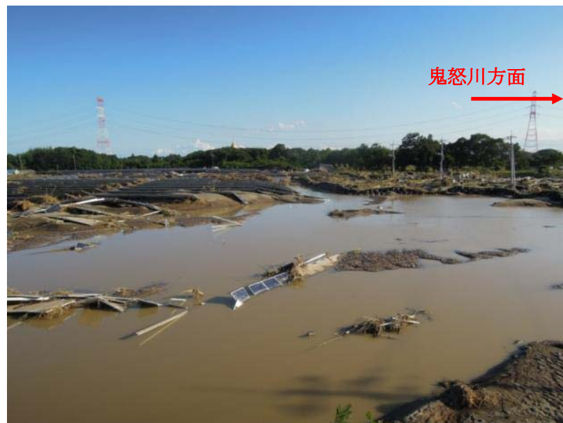
写真 3-2 太陽光発電所設置個所。砂丘部から下流側に撮影。
