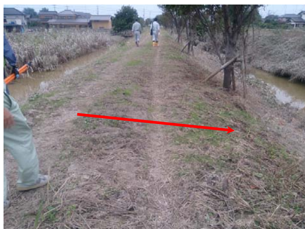
写真 4-19 八間排水樋管への水路の状況
