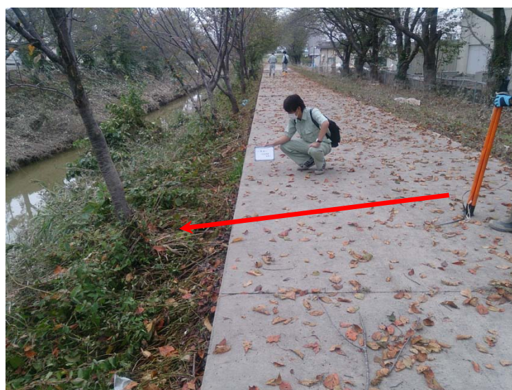
写真 4-10 きぬ医師会病院側から小河川への氾濫水の流入跡
