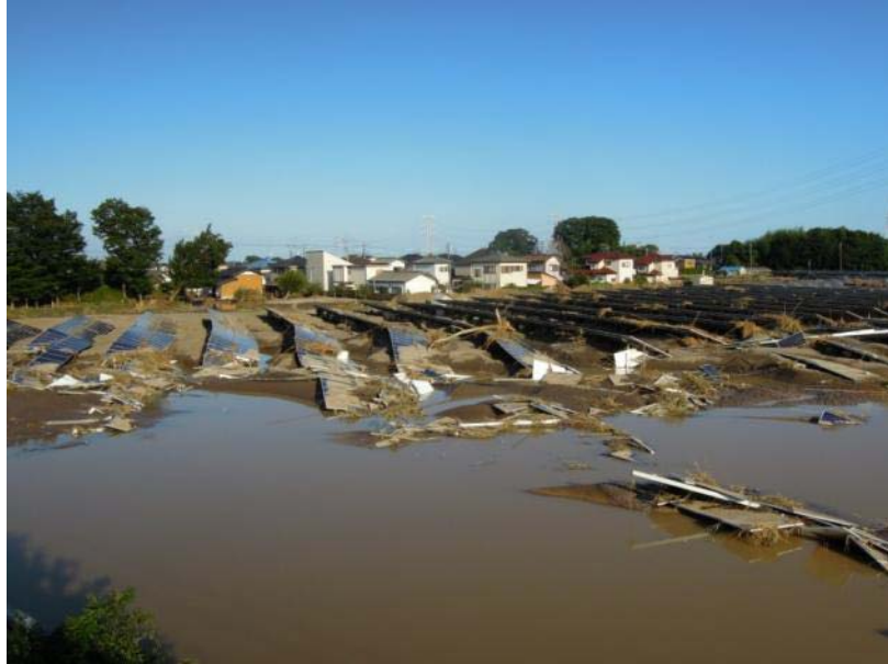
写真 3-3 太陽光発電所設置個所。砂丘部から堤内地側を撮影。
