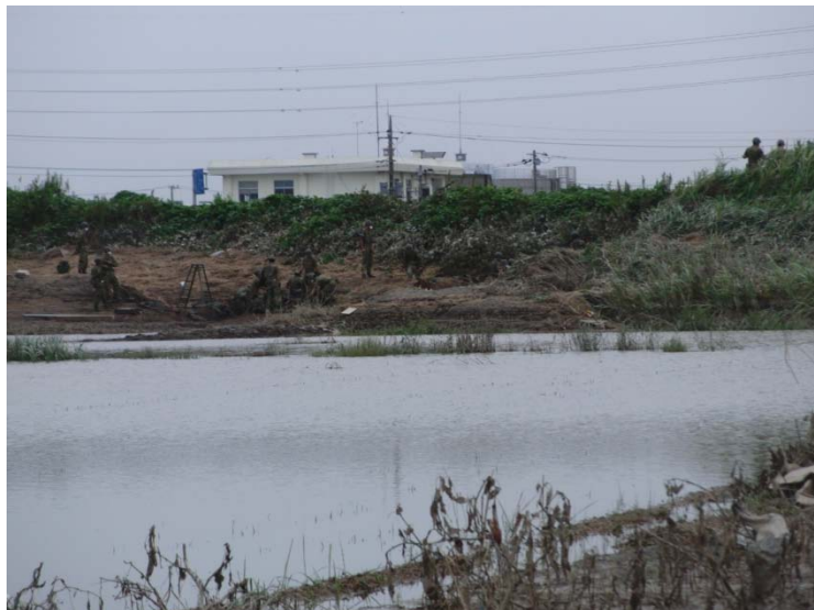
写真 4-3 堤防決壊箇所 復旧作業状況
