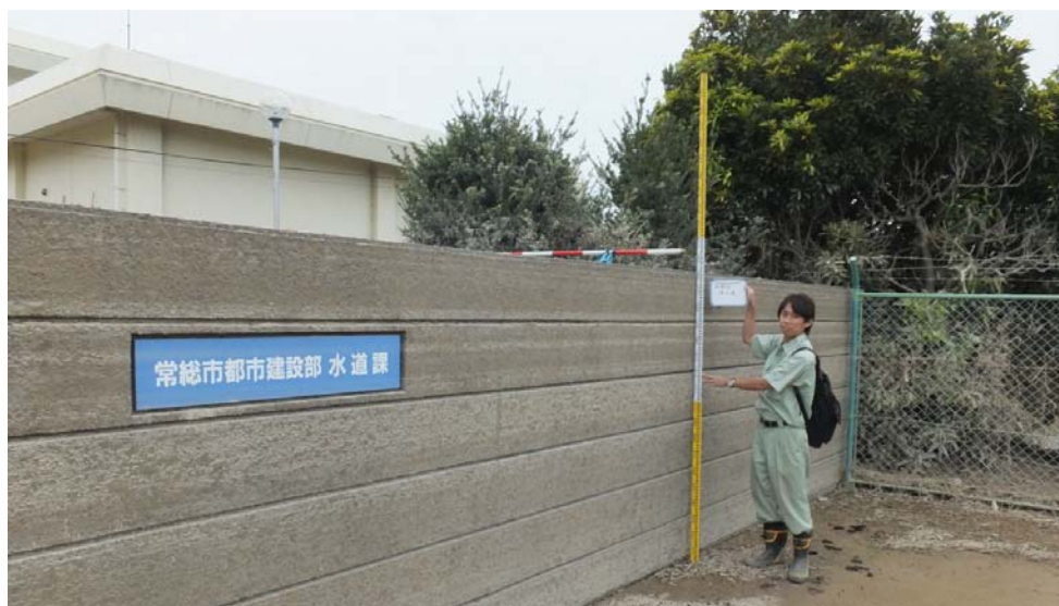
写真 6-7 相野谷浄水場の浸水深痕跡
