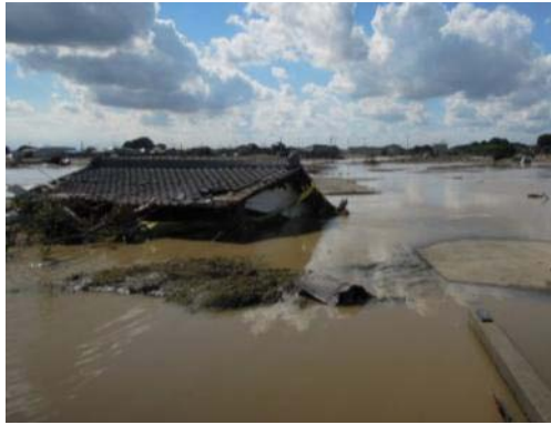
写真 1-4 流出し屋根のみ残った家屋
