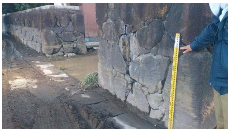
写真 5-27 家屋の入口、塀に浸水痕跡が残っている。
