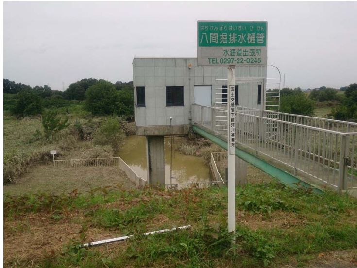
写真 4-21 八間排水樋管の状況
