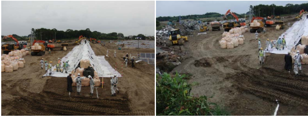
写真 3-14 左岸下流からの復旧状況
