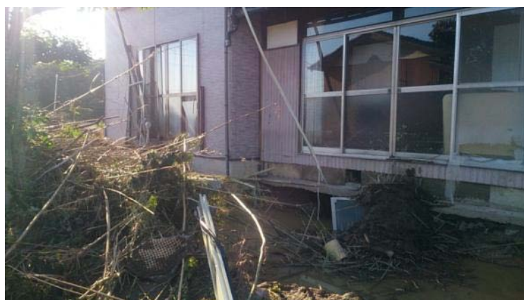
写真 5-25 家屋の下部が洗堀している。漂流物がある。
