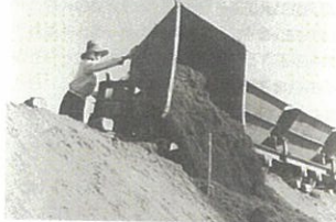
『撒き出し』(大正～昭和30年代) 機関車を用いて土を運搬する場合、特に締固めは行わなかった
