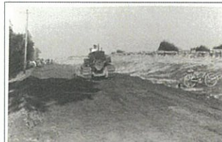
『ブルドーザーによる敷き均し・締固め』(昭和30年代以降) 戦後は、米軍のブルドーザーの払い下げがあり、施工効率を上げることができた
