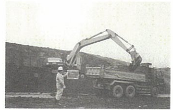
『バックホウ』 昭和40年代より使用(締固めにも使用)
