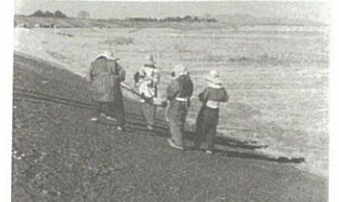
『タコつきによる締固め』(～昭和30年代) 重さ10～15kgの石タコを6～8人掛で引張り上げた後に落下させて締固める
