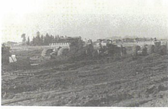
『スクレーパー』(昭和30年代) 運搬距離が短い施工箇所に使用
