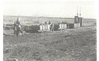
『人カトロッコ』 大正～昭和初期では『トロッコ』により土を運搬するようになった
