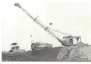
『ドラグライン』(昭和30年以降) ブームが長く、施工範囲が広いため河川工事に多く使用、水中掘削も可能
