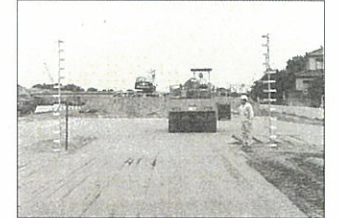
『タイヤローラーによる締固め』(昭和30年代以降)
