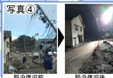
陥没復旧前 陥没復旧後 国道249号緊急復旧完了
