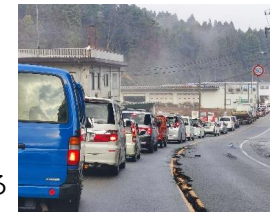
▲被災直後の国道249号 (穴水町乙ヶ崎)
