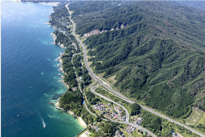
三陸沿岸道路（岩手県山田町）
