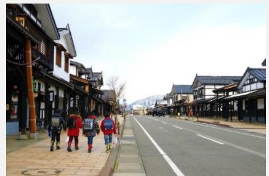
無電柱化・まちづくりとの融合（新潟県南魚沼市）
