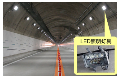
道路照明のLED化
