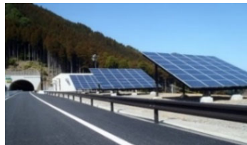
道路空間の太陽光発電設備
