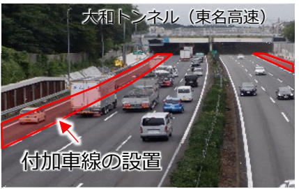
大和トンネル (東名高速) 付加車線の設置 ボトルネック対策 (付加車線の設置)
