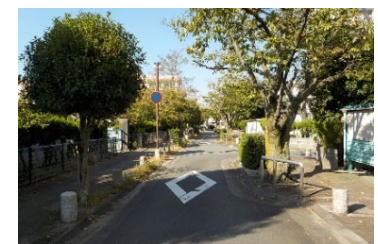
狭さくの設定による走行速度の抑制
