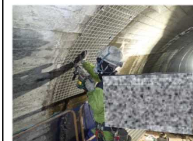
修繕の様子（剥落対策）
