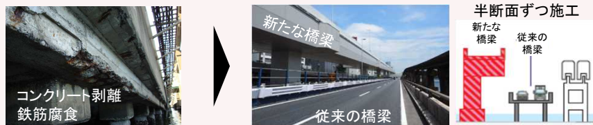
構造物全体の架け替えを実施
