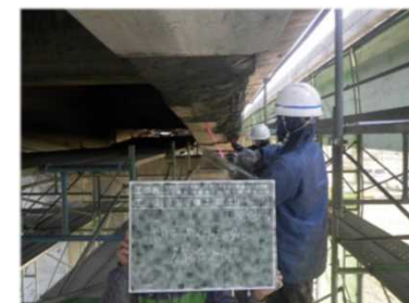
修繕の様子（断面修復）
