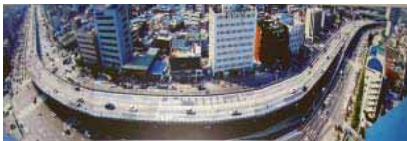
図-3 工事着手前
