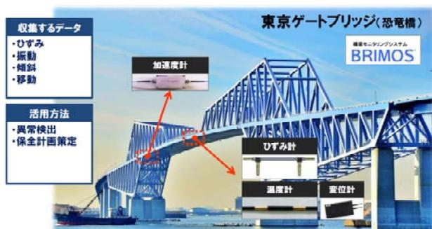
図2 センサー類を用いた橋梁モニタリングシステム
