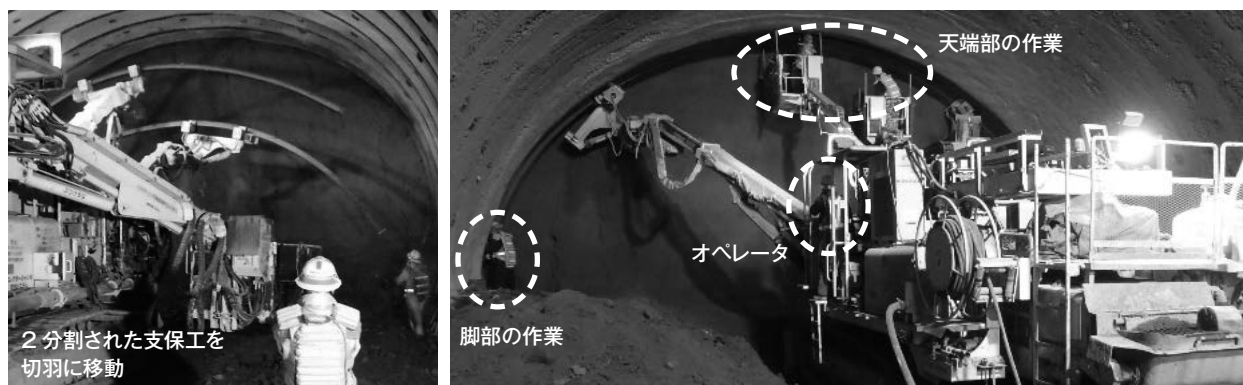
写真-1 現行のエレクター搭載型吹付機による施工方法
