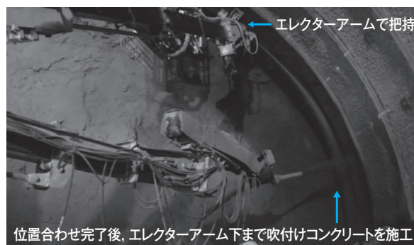
写真－11 右側鋼製支保工脚部固定状況
