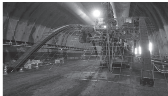
写真－9 溶接金網取付完了
