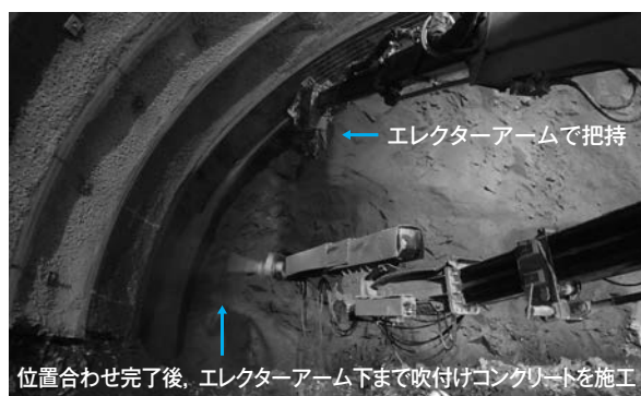
写真－13 左側鋼製支保工脚部固定状況
