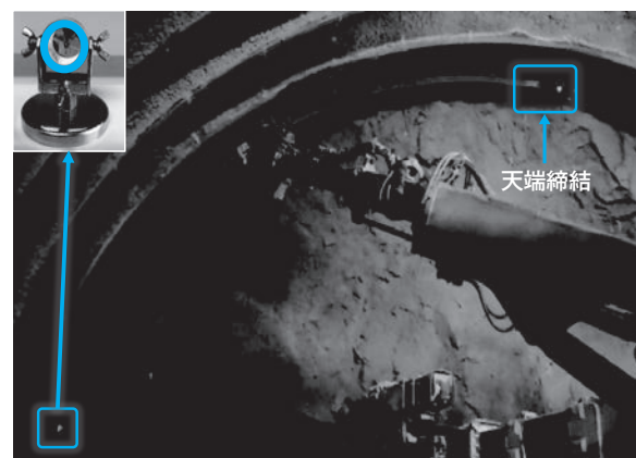
写真－12 左側鋼製支保工位置合わせ状況
